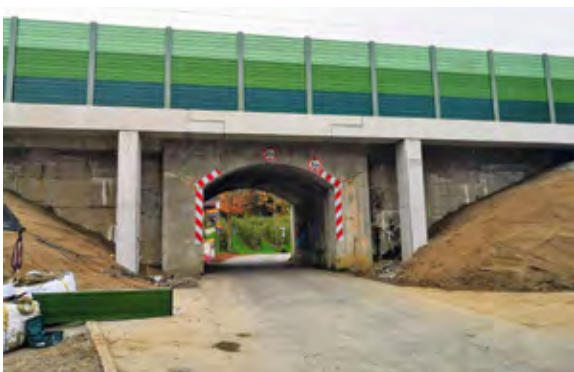
Torsionsbalken über die Rathausstraße in Bodolz sowie die Wackerstraße in Lindau
