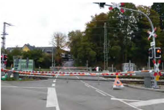
Für die Hochstastfahrten mussten zahlreiche Bahnübergänge, wie hier in Lindau-Aeschach, durch Bahnübergangsposten abgesperrt und gesichert werden
