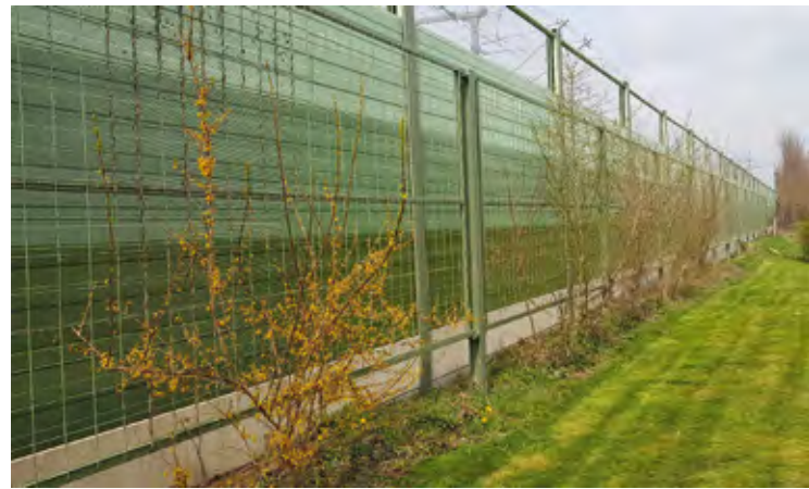
Begrünung der Schallschutzwand mit Rankgittern
