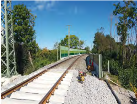
Schallschutzwände im Bau mit rückwärtiger Rankgitterkonstruktion auf dem Bahndamm in Wangen (Allgäu)
